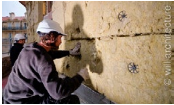
Auberge rue Trinquet, réhabilitation reconstruite BDM Argent/phase réalisation/oct 2020
